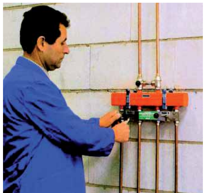
Die Tankverriegelung garantiert, dass nur ein Tank geöffnet werden kann.
